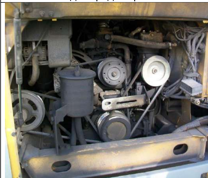
ПАЗ-423470, Изношенные ремни передачи
