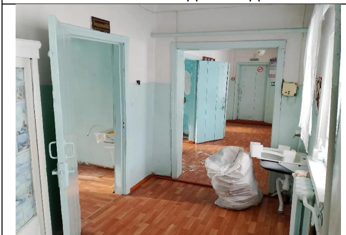
Здание ФАП в Бобково, Состояние отделки
