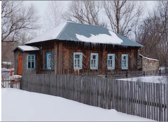
Здание ФАП в Бобково, Главный вид с юго-запада
