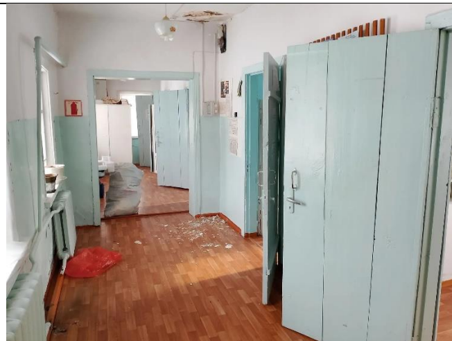
Здание ФАП в Бобково, Главный коридор
