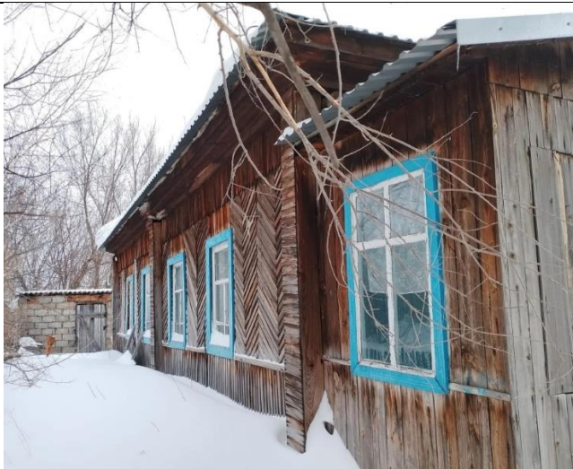
Здание ФАП в Бобково, Вид с северо-запада
