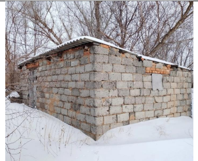
Здание ФАП в Бобково, Склад угля и дров
