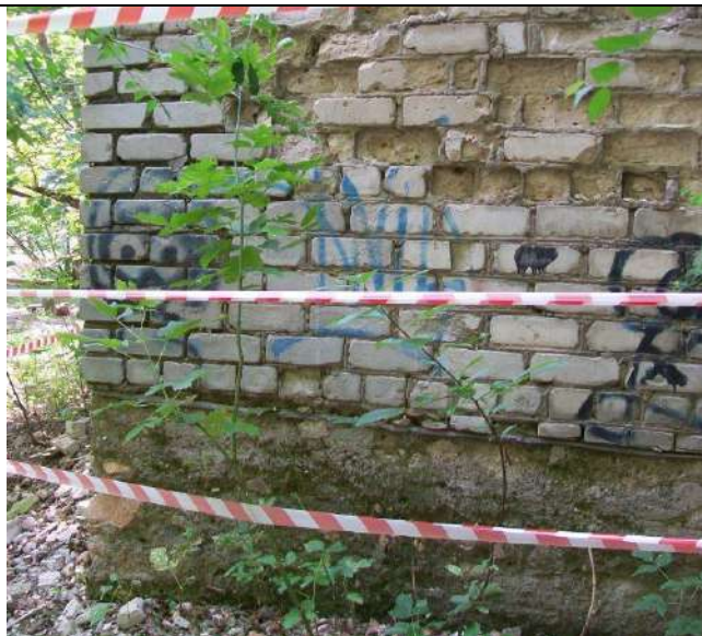
Клуб в Потеряевке, Бетонный цоколь
