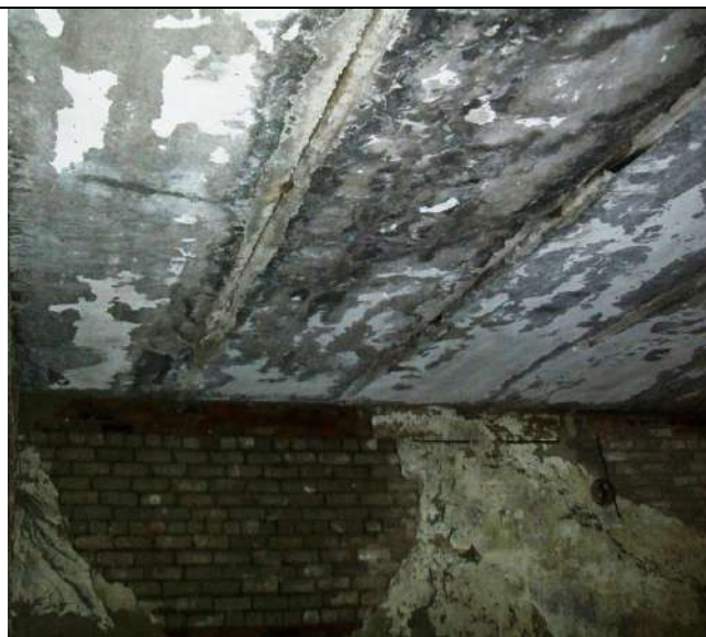
Клуб в Потеряевке, Плиты перекрытия
