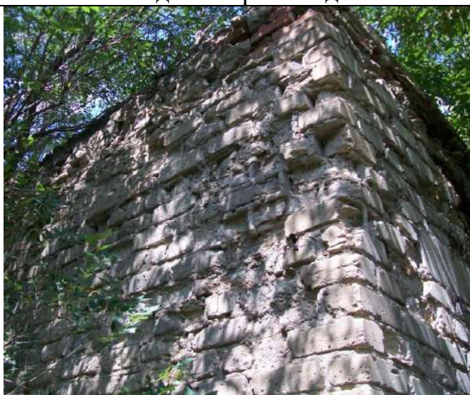
Клуб в Потеряевке, Юго-восточный угол здания
